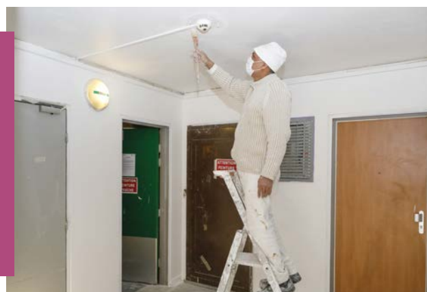
Pendant les travaux Un appartement de courtoisie est à la disposition des habitants pendant l'intervention des ouvriers chez eux.
