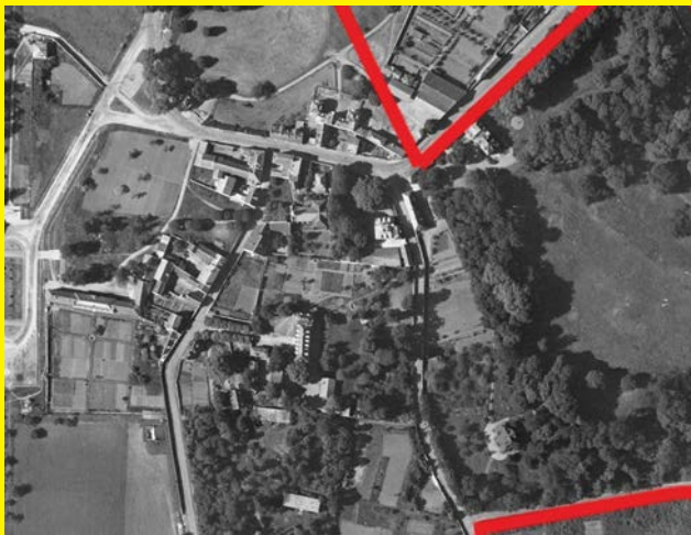
Vue aérienne du centre bourg en 1947. On reconnaît l'Orangerie à gauche et l'église au centre.
